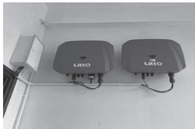
Hình 3. Lắp đặt công trình điện mặt trời 5kWp
